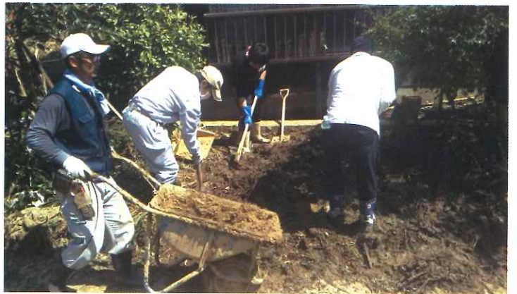
南柏における土砂撤去作業の様子
